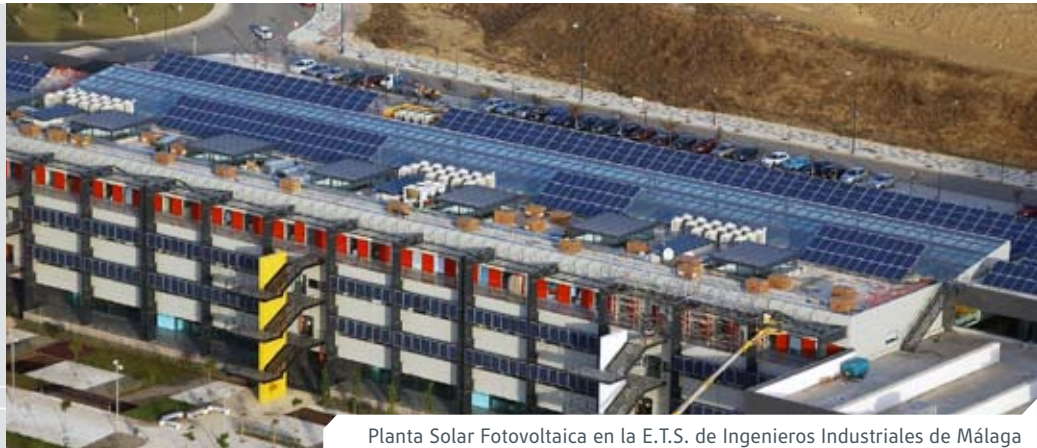
Planta Solar Fotovoltaica en la E.T.S. de Ingenieros Industriales de Málaga
