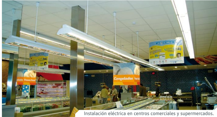
Instalación eléctrica en centros comerciales y supermercados.
