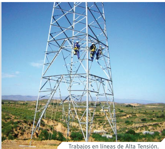
Trabajos en líneas de Alta Tensión.
