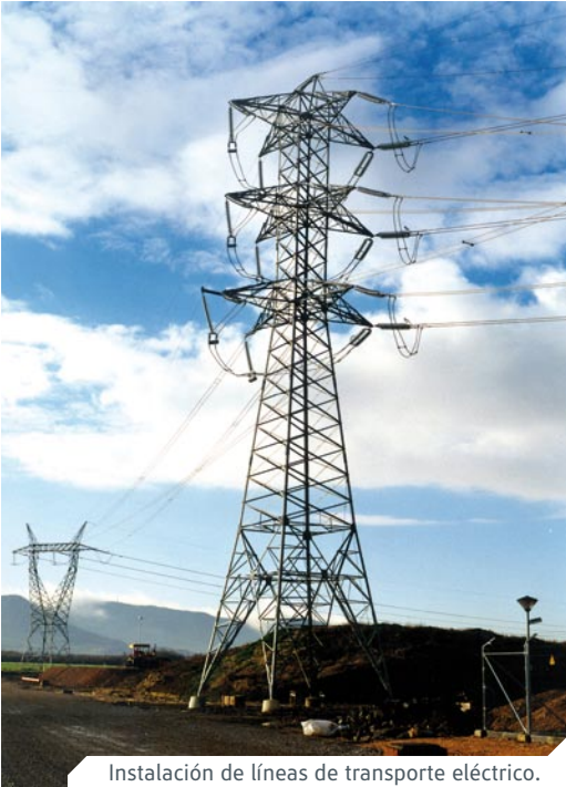
Instalación de líneas de transporte eléctrico.
